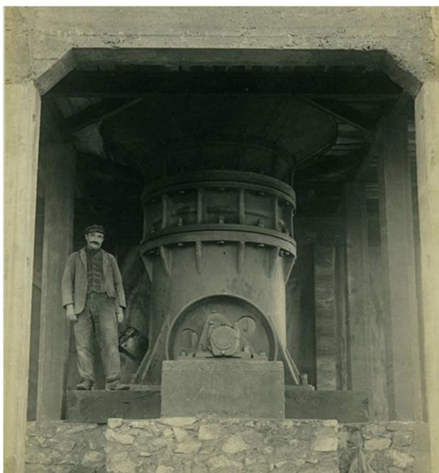
Le concasseur d'une capacité de 80 tonnes par heure
